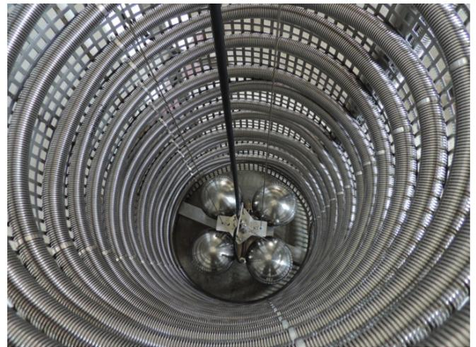
**Vue plongeante sur le câble chauffant autorégulant inséré dans un flexible de protection en acier inox et sur l'électrode flottante Ex**
